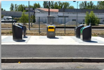
Création de 5 colonnes enterrées à la gare
