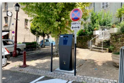
Installation d'une borne électrique, place Alègre (en partenariat avec la FDEE)
