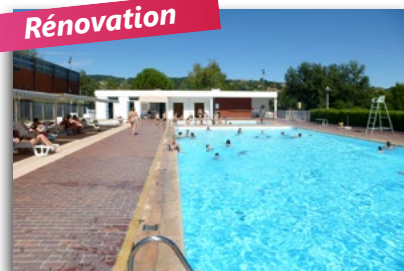
Changement du système de chloration de la piscine municipale
