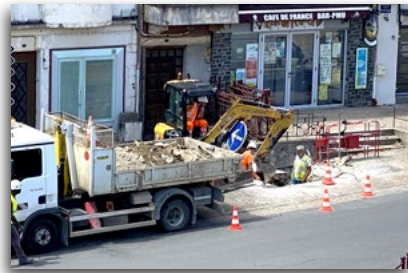
Remplacement des 19 lampadaires du centre-ville
