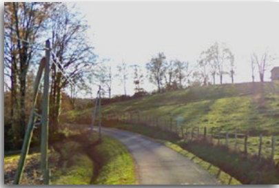
Réfection route de Gorsat/Garavet
