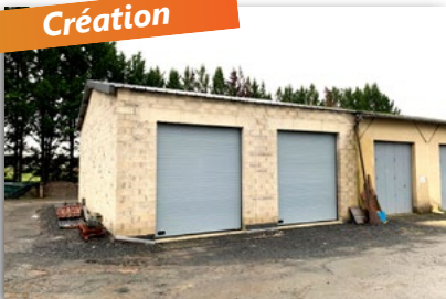
Extension du centre technique municipal
