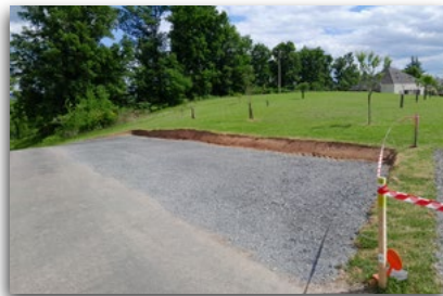
Création d'un parking à Brochat
