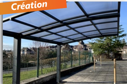
Installation d'un carport au groupe scolaire Coût communal des travaux : 2 500€
