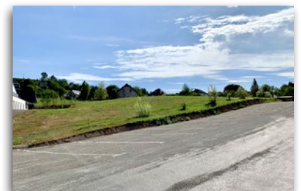
Création d'un parking de 31 places à proximité du groupe scolaire Goudronnage du parking scolaire
