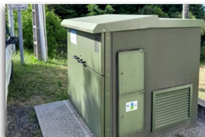
Remplacement de toutes les armoires d'éclairage public
