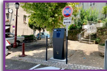
Installation d'une borne électrique, place Allègre Coût des travaux (FDEE 19) : 35 000€
