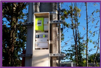
Remplacement de 17 coffrets d'éclairage public (2 ème tranche) Coût communal des travaux : 35 800€
