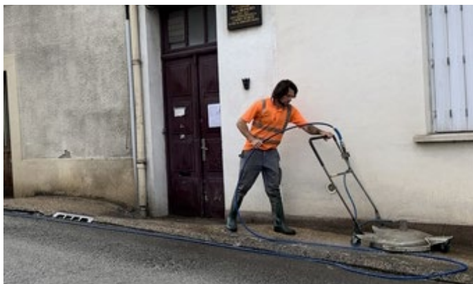
Décapage des trottoirs du centre-ville
