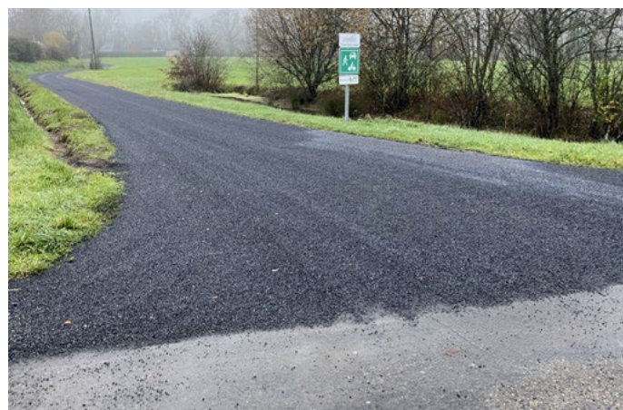
Réfection voirie au Moulin de Bridal
