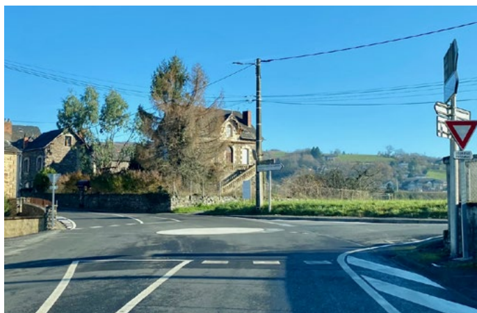
Création d'un rond point franchissable + 3 passages piétons
