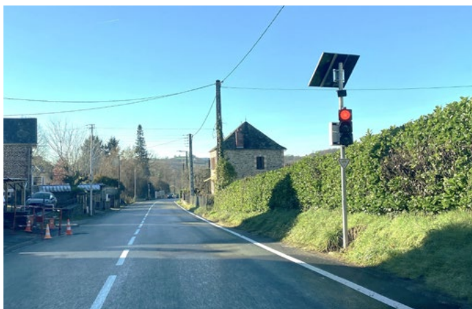
Installation de feux tricolores
