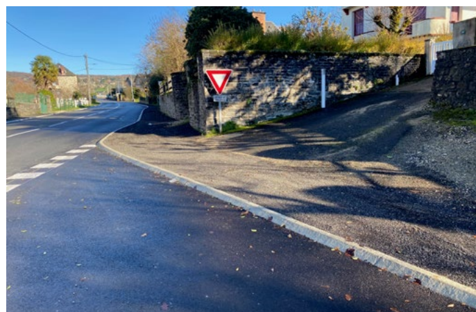
Création de trottoirs + avaloirs d'eau pluviale
