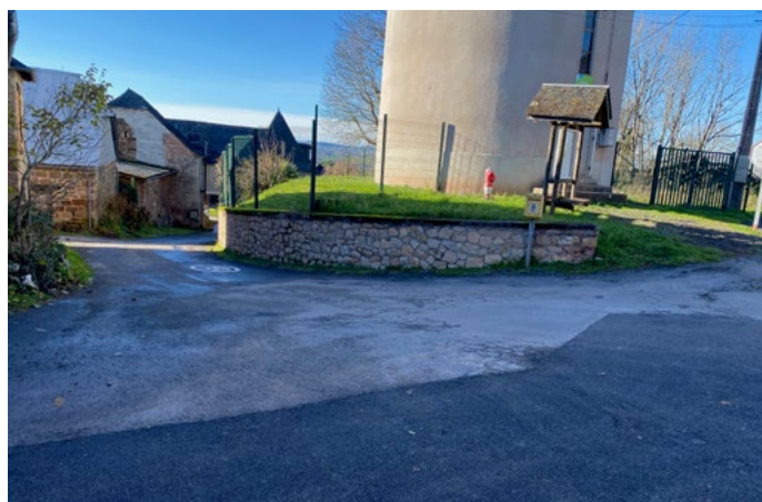
Aménagement du carrefour devant la chapelle de Brochat
