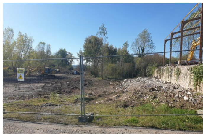
Démolition des anciens bâtiments au site des ardoisières
