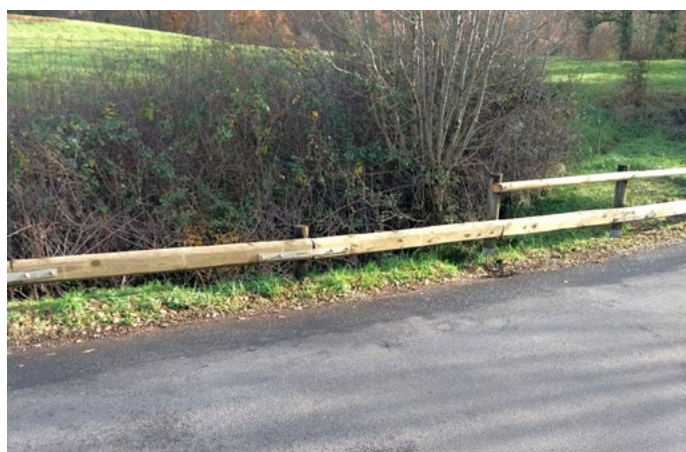
Changement des lisses du pont de Laval
